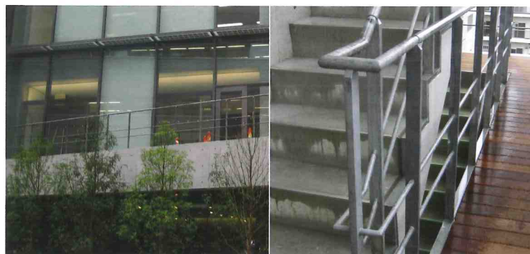
手すり、および階段手すりの低光沢処理
